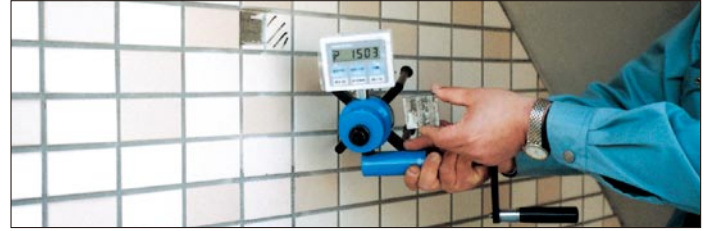
(外装タイル接着強度測定)
