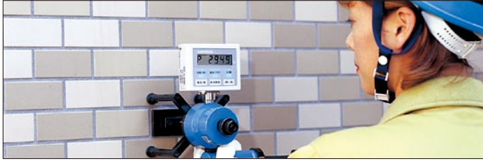
(外装タイル接着強度測定)
