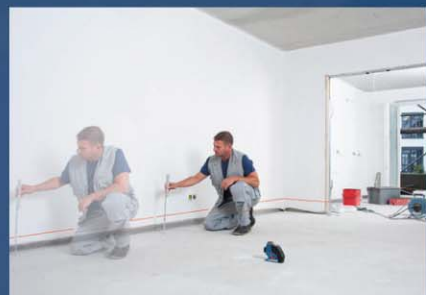
②レーザー墨出し器で高さを確認
